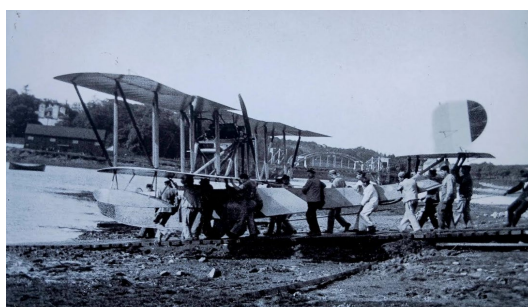
Mise à l'eau, collection particulière, source Océanide
