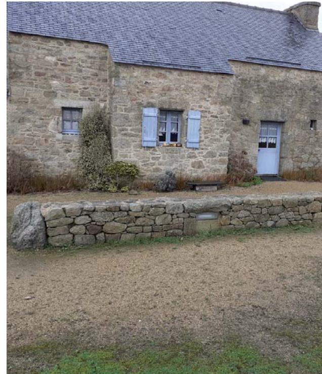
Muret d'assise en pierre sèche granitique
